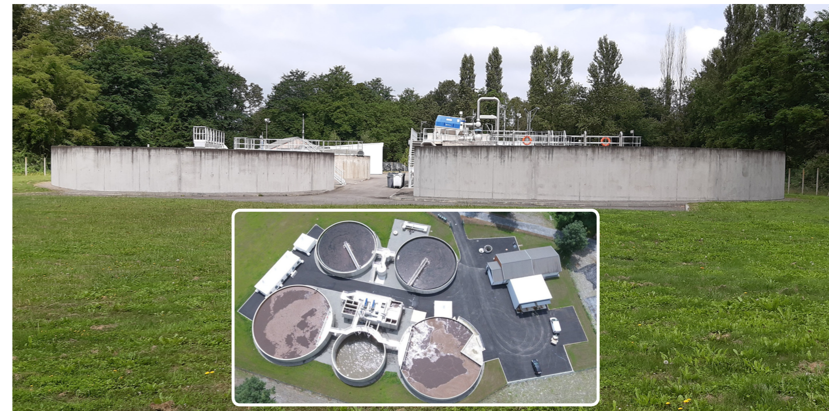
▲ Station d'épuration de Nay (64)
